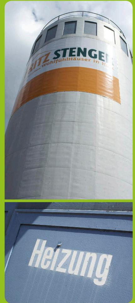
Kein Span bleibt ungenutzt: Im Betrieb werden alle Schnittabfälle in einem Silo gesammelt und zur Beheizung der Produktionshallen im Winter genutzt.
