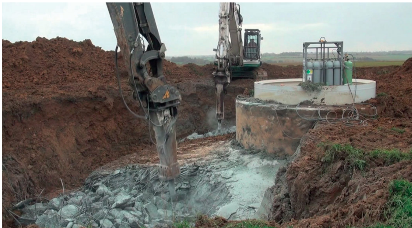
Photo 4 – Démantèlement d'une fondation d'éolienne à Criel-sur-Mer (76).
