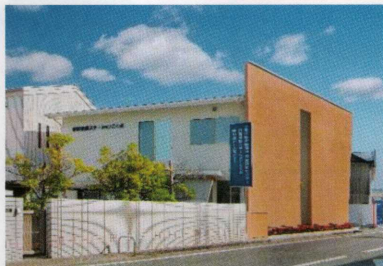
外観 北西側より
