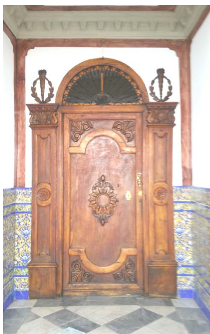
Il. 8. Puerta de la casa familiar de Ruiz Torres
