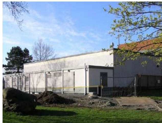
Baustelle an der Trafostation (Foto: Dr. Kießig)
