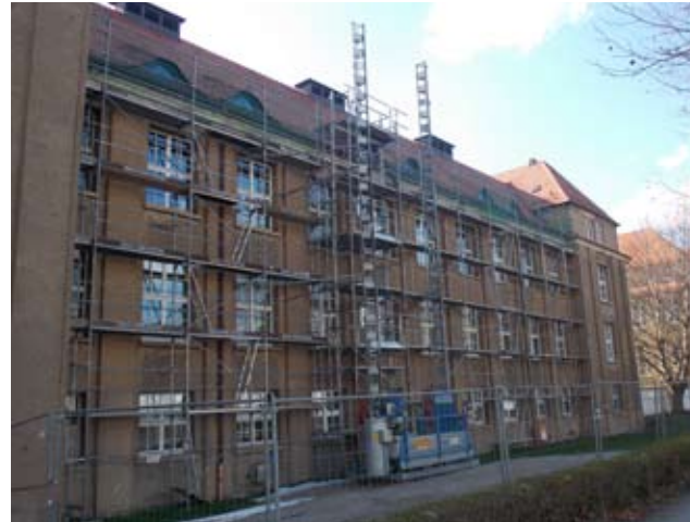
Baustelle an der Pathologie (Foto: sijn)
