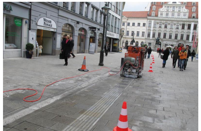
Blindenleitsysteme werden in den Boden eingefräst (Quelle: B4B Wirtschaftsleben Schwaben)
