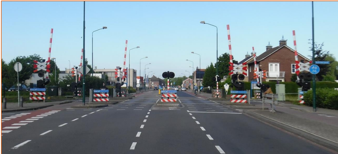
Afbeelding 1 Overweginrichting, gezien vanaf oostzijde overweg
