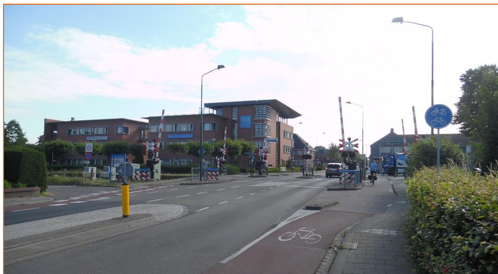
Afbeelding 3 Overgang fietsstrook – fietspad aan westzijde overweg
