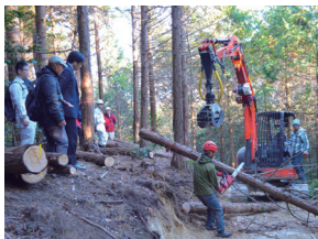
搬出間伐の現場作業を見学 (12/8 今治・玉川町)
