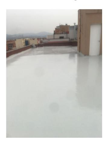
Una vez aplicada la última capa de poliuretano alifático flexible **PU-400 Flex** con un consumo de 300-400 gr/m<sup>2</sup> en 24 horas ya es totalmente transitable para trafico intenso.
