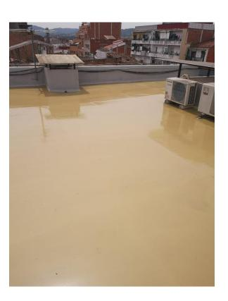
Aplicación con rodillo de una ultima mano de sellado y terminación del sistema con poliuretano alifático PU-400 Flex con una dotación de 300 gr./m2
