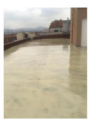
Aplicación con llana dentada de una segunda mano de poliurea en frío PS-300.EPS con una dotación de 1,5Kg. a 2 kg./m2
