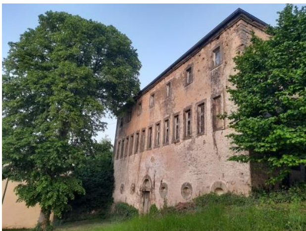
Haus der ehem. Schleiferei
