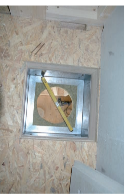
Schachtauflager montieren
