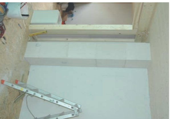
Obergeschoss fertig montiert (Oberfläche zum Streichen oder Verputzen)
