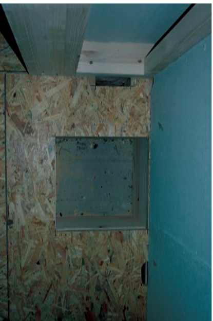
Aussparung Decke über Aufstellungsraum von oben
