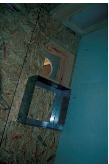
Einlage nbb mit Ausschnitt und Schachtauflager
