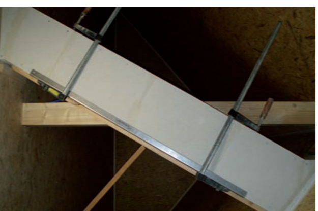
Montage der Verstärkungswinkel (in Schacht-Element verschraubt)
