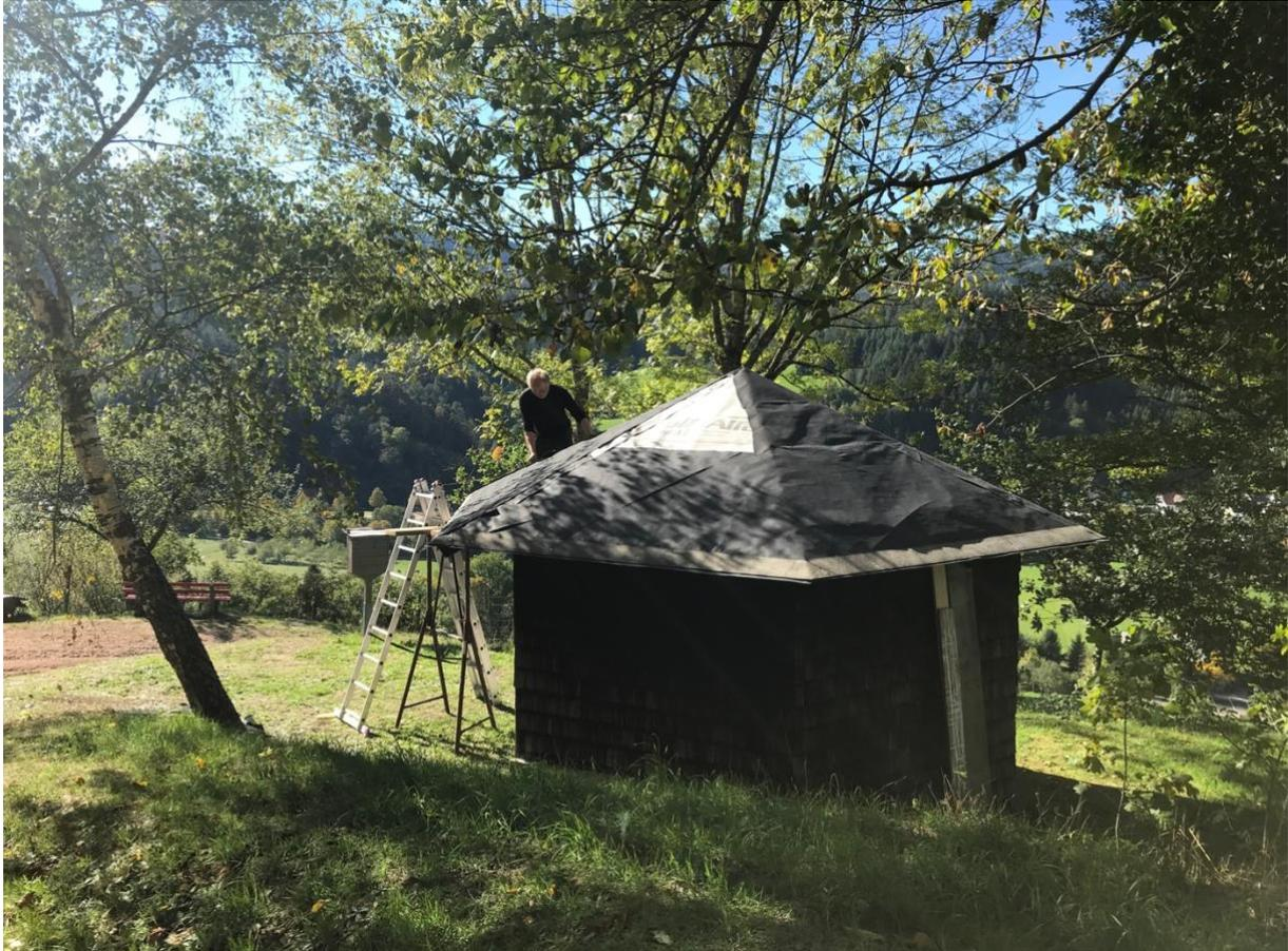
Die neuen Bitumenschindeln werden verlegt.... (Foto C.Ostgathe)
