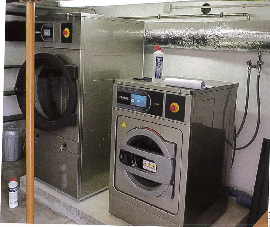
Ein stabiler Untergrundsokkel und ein separates Ablaufsystem ist die Voraussetzung für die Langlebigkeit der Spezialwaschmaschinen und Trockner.
