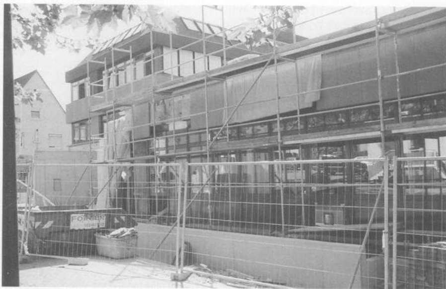
Das Rathaus zu Beginn der Umbauphase (Foto: A. Imhoff)
