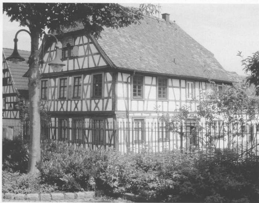
Das Hauptgebäude des Museumskomplexes, Standort der zukünftigen volkskundlichen Schausammlung
