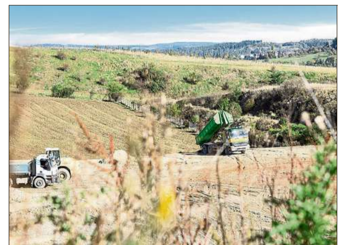
Auch in der Erddeponie Balingen stehen Arbeiten an.
