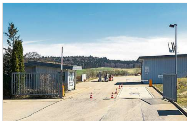
Die Erddeponie in Albstadt wird ertüchtigt.
