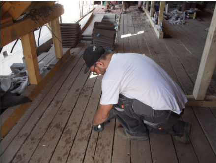
Traçage des emplacements des murs et des portes
