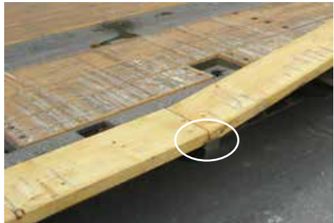
Figur 12 - Bretterstöße auf Traverse
