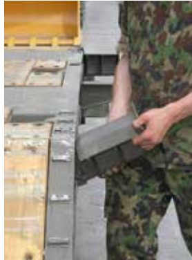
Figur 10 - Traverse einhängen
