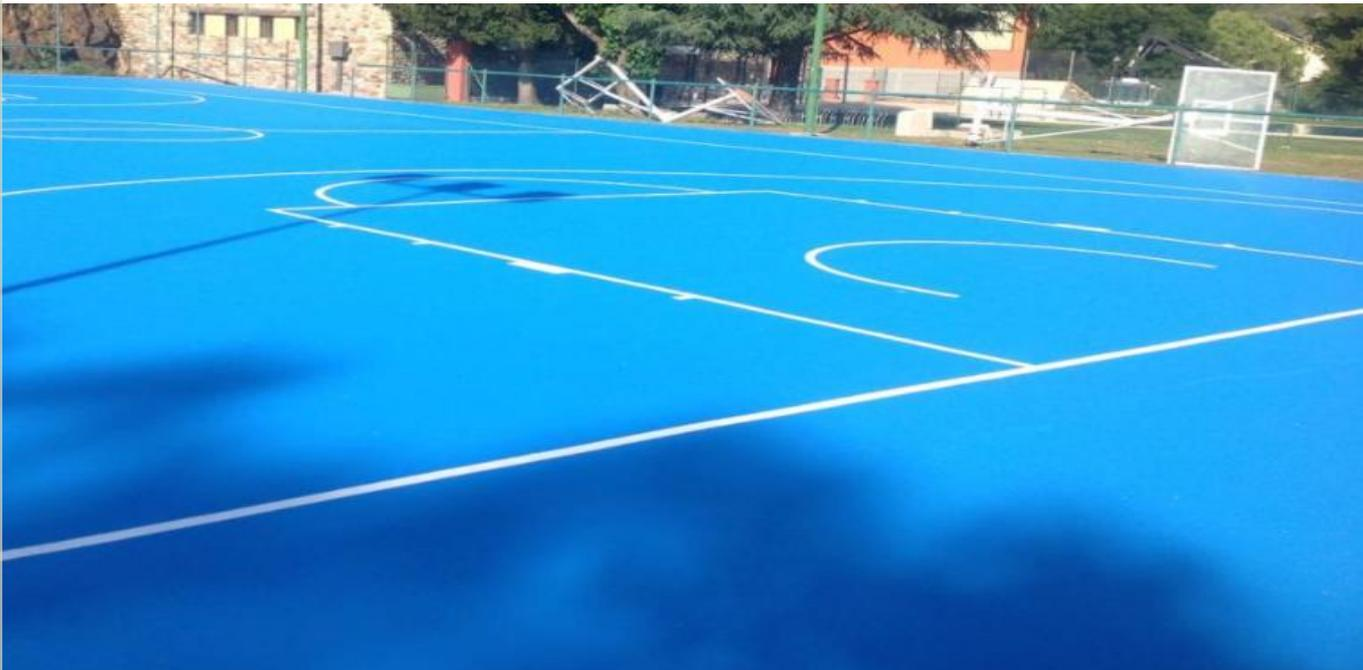
Pavimento para pistas deportivas mediante la aplicación de resinas al agua de aplicación in-situ.
