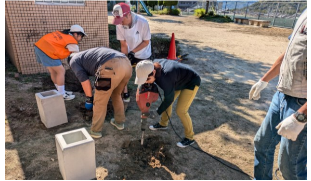
基礎コンクリートの設置作業
