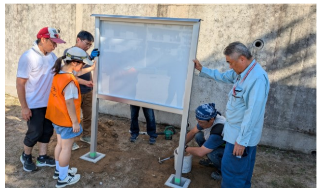
掲示板の建て込み作業
