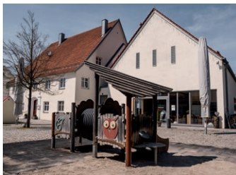
Nach Renovierung und Bau des Dorfstadels (2021)
