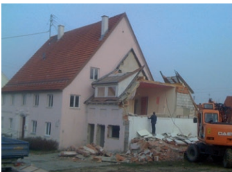
Gasthaus Lamm in Buch während der Abbrucharbeiten (2010)
