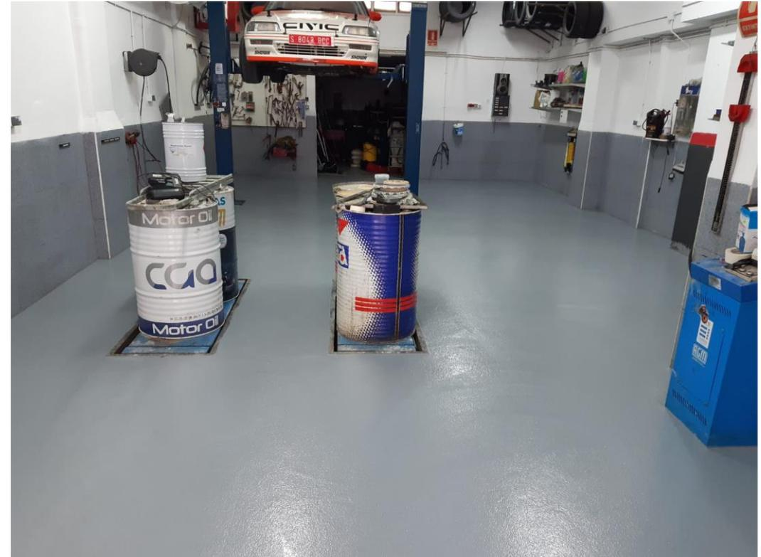
Aplicación a rodillo de demarcación de zonas con pintura epoxi 100% sólidos **Epox-311** en la totalidad de la superficie a tratar. 250 gr/m<sup>2</sup>.
