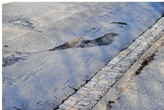
Mittlerweile gleicht die S 177 in Feldschlößchen und Seifersdorf einem Flickenteppich. Aktuell sorgen auch wieder etliche Schlaglöcher für zusätzlichen Lärm.
