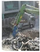
産廃施設と言えば、騒音、汚水、ほこりを思い浮かべる。建屋の中でコンクリートや木材の破砕作業が行われているが、外からはかすかに騒音が聞こえてくる程度である。雑排水も粉じんも見かけないのは、水を使わずに処理を行っていることと、上からミストを出しながら作業を行い粉じんを外部に出さない工夫が施されているからだ。密閉された建屋内で粉砕作業を行うショベルカーは、排気ガスを出さないよう全て電動(メーカーと独自開発)となっている。
