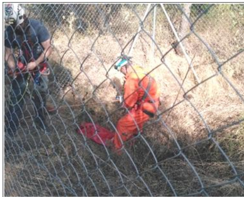
Fig. 6. Descenso al pozo n.º 3
