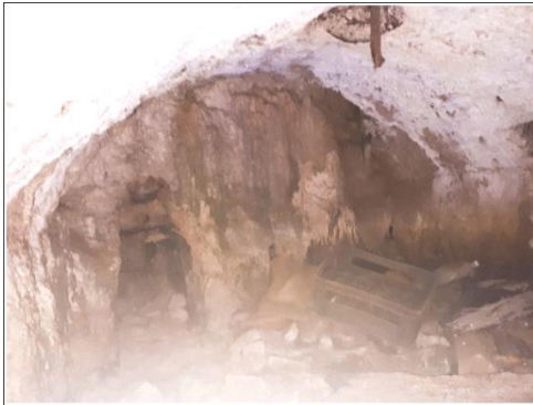
Fig. 9. Cárcavo anexo al acueducto
