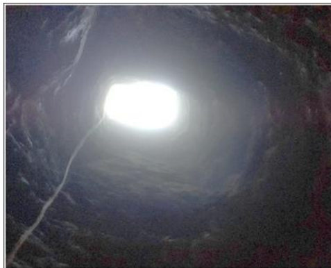
Fig. 7. Encañado del pozo n.º 3
