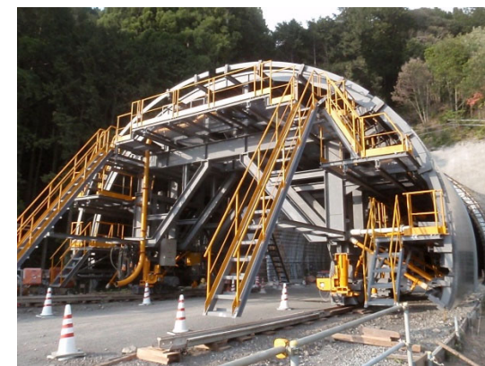
セメント (型枠) を設置しコンクリートを打設する
