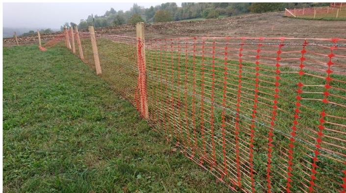
**Figure 29.** *barrière avec barbelé plus pose de grillage avertisseur pour délimiter la zone chantier*
