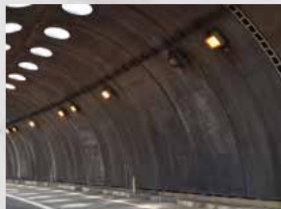
トンネル・アンダーパス
