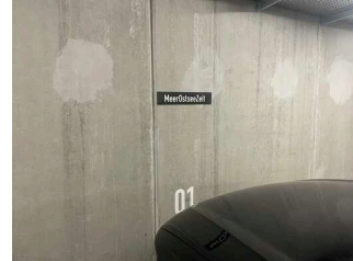
Parkplatz in der Tiefgarage
