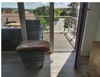
Ebenerdiger Zugang zum großen Balkon
