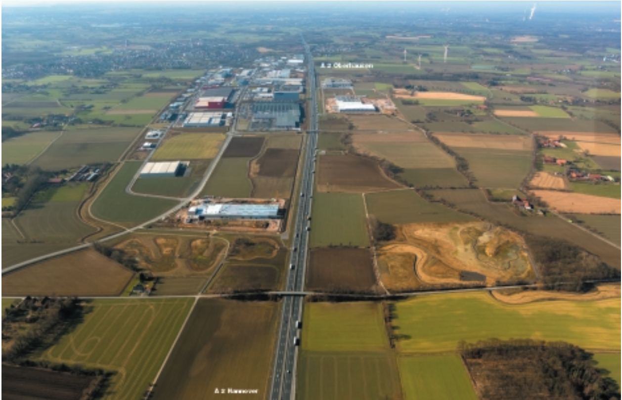
Weetfeld ca. 2013: „Ersatzauen“ als Entwässerungssystem des Inlogparc. In dieser Blickrichtung erschließt sich dem Betrachter das ganze Ausmaß der fortschreitenden Flächenumwandlung.
