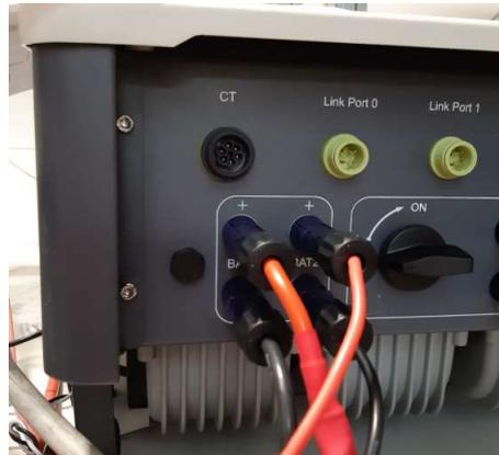
Figura 14 - Connessione potenza DC lato inverter con due ingressi batteria popolati
