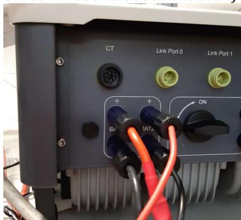
Figura 9 - Connessione potenza DC lato inverter con un doppio ingresso batteria popolato
