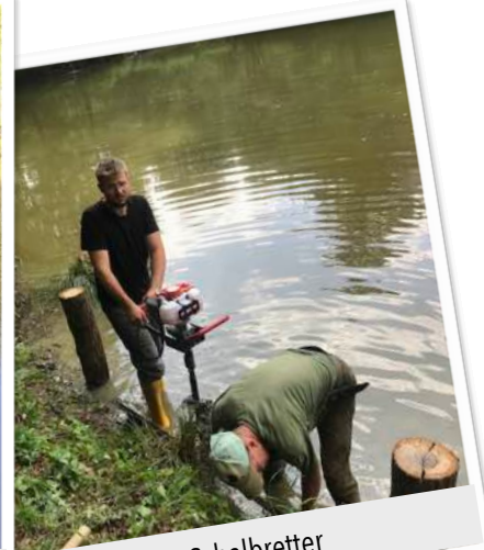
Anbringen der Schalbretter
