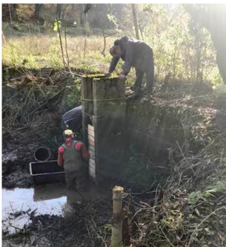
Zum Schluß wird der Mönch wieder abgedichtet.
