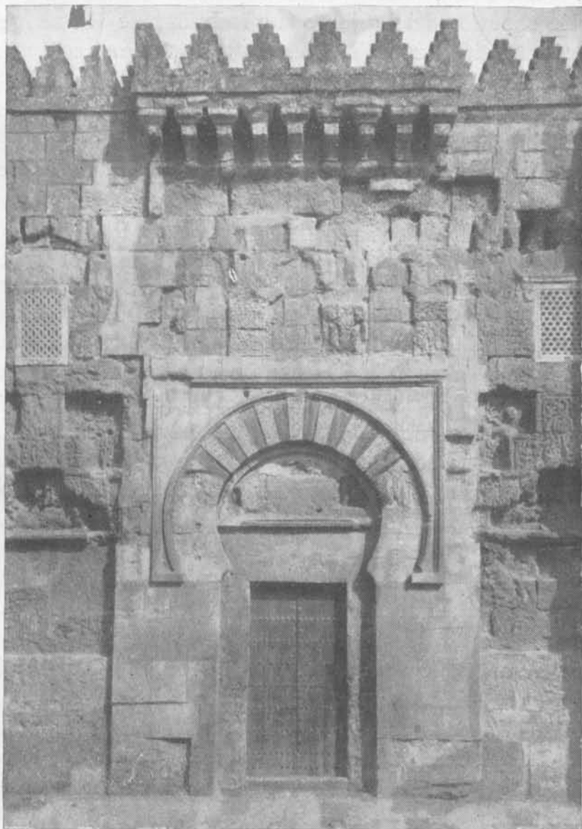
Estado actual de la portada de Mohamed I, después de quitadas las lonjas en 1928.
