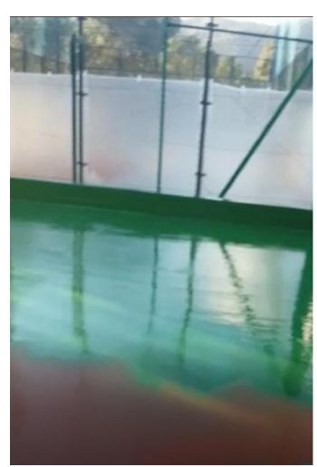
Una vez aplicada la última capa de poliuretano alifático flexible **Pavifer-400 Flex** con un consumo de 300-400 gr/m<sup>2</sup> en 24-48 horas ya se puede transitar.
