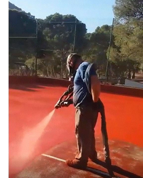
Limpieza general y diamantado de toda la superficie para la aplicación de una primera (1ª) mano de imprimación base epoxi 100% sólidos **PS Primer** en la totalidad de la superficie a tratar. 300 gr/m²
