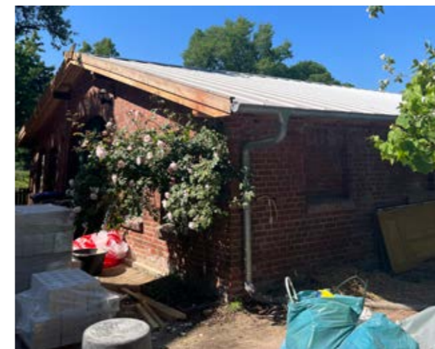
Abb. Beispiel Umnutzung Remise zu Gemeinschaftswohnräumen
