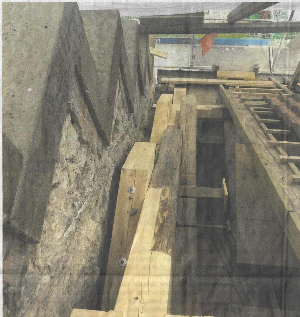
Die Bundachse am nördlichen Staffelgiebel der Heiligenzimmerner Kirche wird umfassend restauriert.
