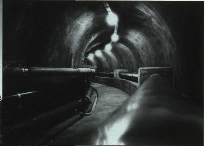
**Oben:** Im 767 Meter langen Werkleitungsstollen sind die unterschiedlichsten Rohre und Kabel verlegt. Wasser, Kanalisation, Strom und Fernmeldekabel sorgen dafür, dass die modernste Infrastruktur auch im Alpengebiet genutzt werden kann.
