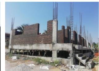
Das Haus der Buben wächst immer mehr. Wir sind beim Parterre im Moment mit den Mauern oben und die Arbeiter fixieren die Schalung für das Dach welches dann bald betoniert wird.
