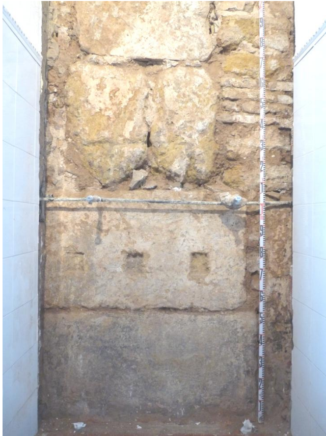
Fig. 6. Sillares reutilizados en alzado nuevo ámbito situado al norte de la nave central de la ermita
