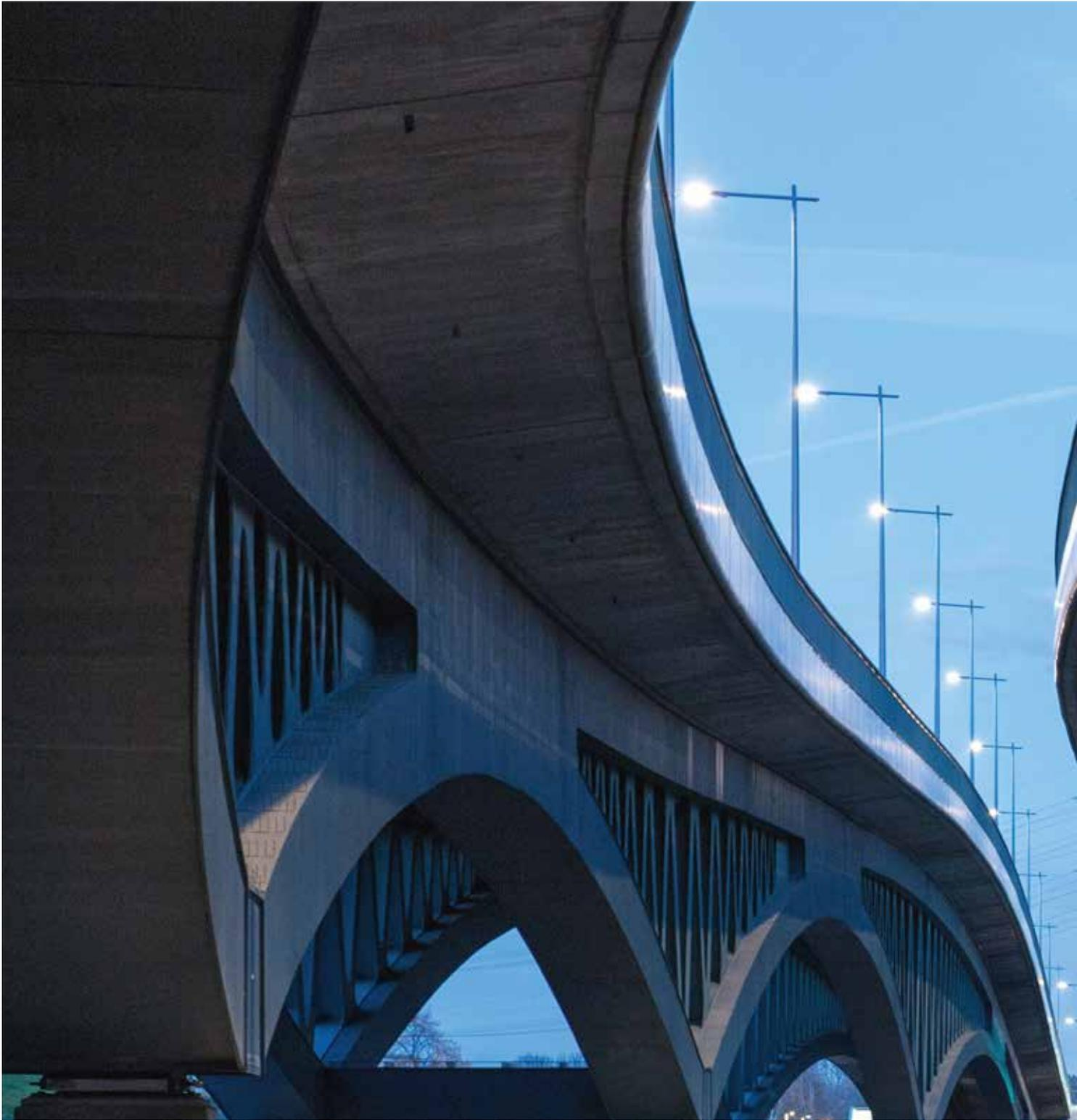
Ungewohnter Durchblick: Die Minna-Todenhagen-Brücke in Berlin besteht aus zwei nebeneinanderliegenden stählernen Durchlaufträgern mit aufgesetzter Betonfahrbahnplatte. Von unten sind auch die massiven Fundamente zu sehen. Der Beton der Stahlverbundbrücke, die als wichtige Süd-Ost-Verbindung über die Spree führt, ist von HeidelbergCement.
