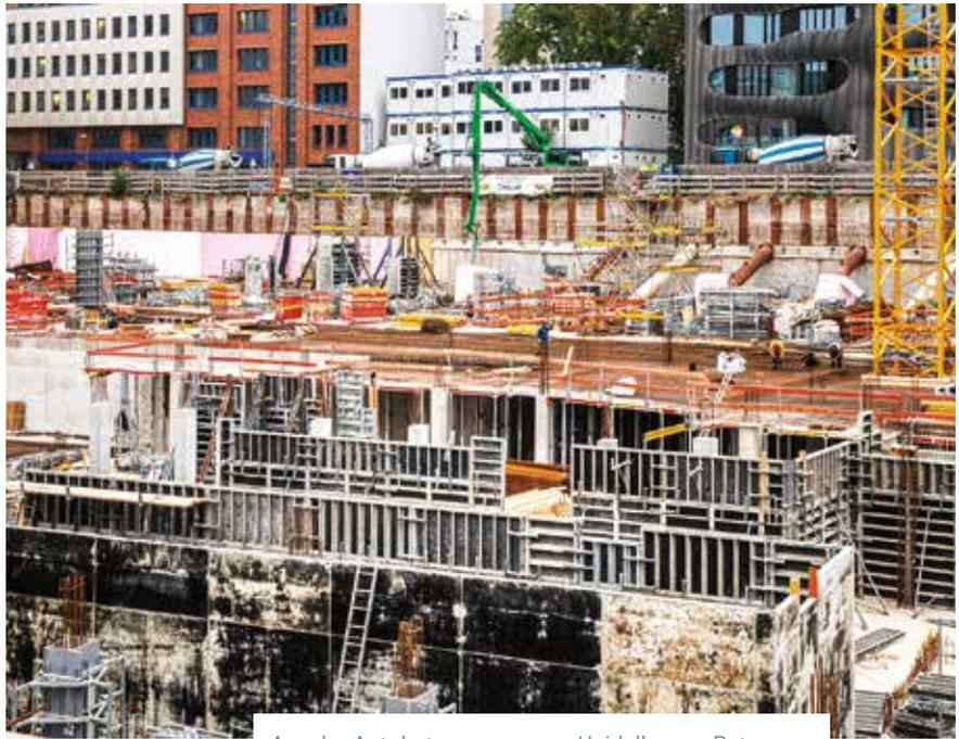
Aus der Autobetonpumpe von Heidelberg Beton wird der Baustoff zur Rohrleitung im Untergeschoss transportiert.
