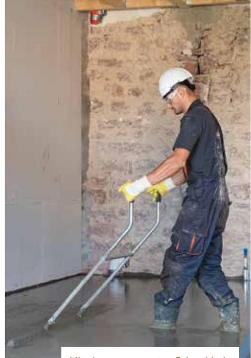
Mit einer sogenannten Schwabbelstange wird der Beton kreuzweise grob- und feinverdichtet.
