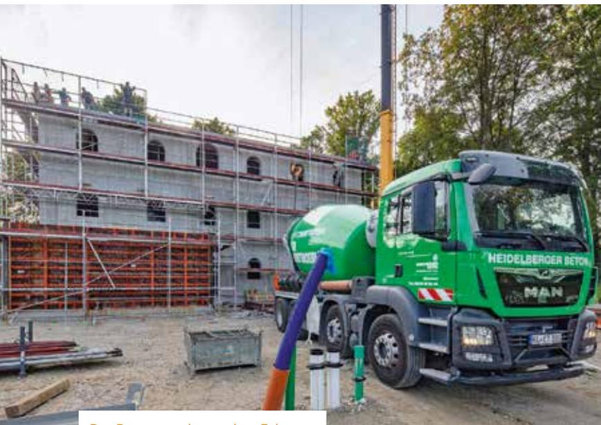
Der Beton wurde aus dem Fahrerischer per Kübel eingebracht.
