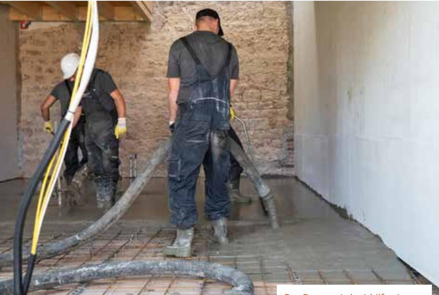
Der Beton wird mithilfe einer Schlauchpumpe eingebracht.
