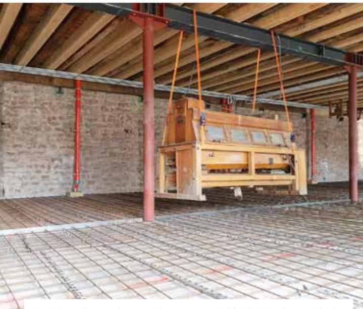
Der Plansichter – dort werden in einer Mühle die Kornbestandteile getrennt – bleibt dem Bau erhalten. Das 2,5 Tonnen schwere Gerät wurde während der Betonage an Ort und Stelle belassen.
