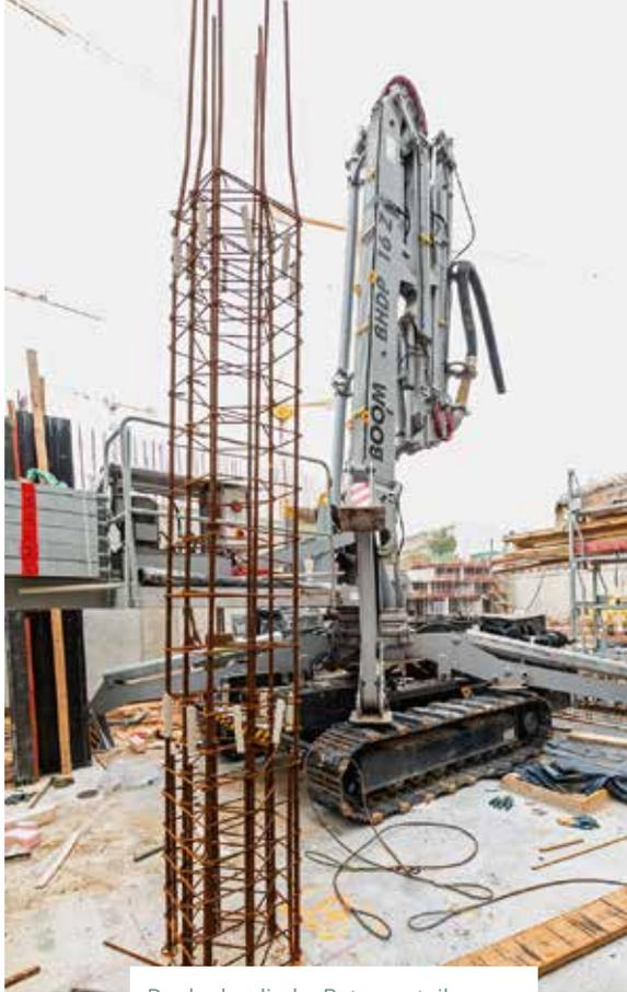
Der hydraulische Betonverteiler BHDP 16 Z 4 stammt vom dänischen HeidelbergCement-Unternehmen Pumps and Trucks.
