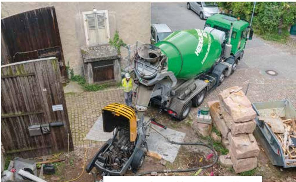
Insgesamt wurden 60 Kubikmeter Easycrète SF angeliefert und mithilfe einer Pumpe an den Zielort befördert.
