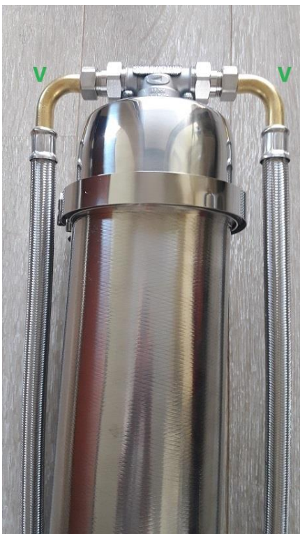
DE - Anschluss an Filtergehäuse
