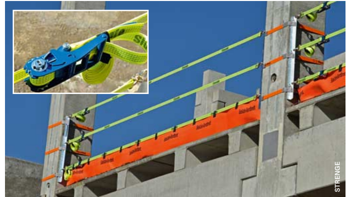
Die »Side Xafe«-Spanngurte können dank Vorspannanzeige sicher auf die nötige Spannung gebracht werden.
