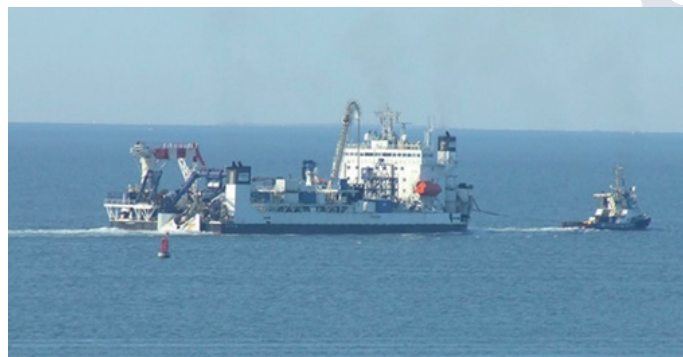
Le CABLE ENTERPRISE au large de SAINT-NAZAIRE Ce câblage a installé au fond de l'océan ces deux câbles de 27 cm de diamètre pour une longueur de 33 km entre la terre et le parc.
