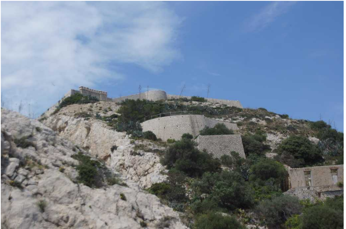
Le fort Ratonneau vu d'en bas, le plus vaste des îles du Frioul, il fut commencé au XVI ème siècle et subit des aménagements successifs. Au début de la 2 ème guerre mondiale il abritait 200 hommes et 4 canons. Les Allemands ont cherché à l'armer et le fortifier davantage mais cela ne fut pas terminé avant les bombardements d'août 1944.
