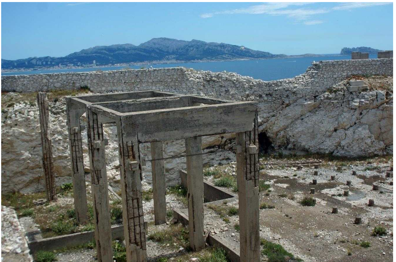
Traces des travaux en béton fait par les allemands
