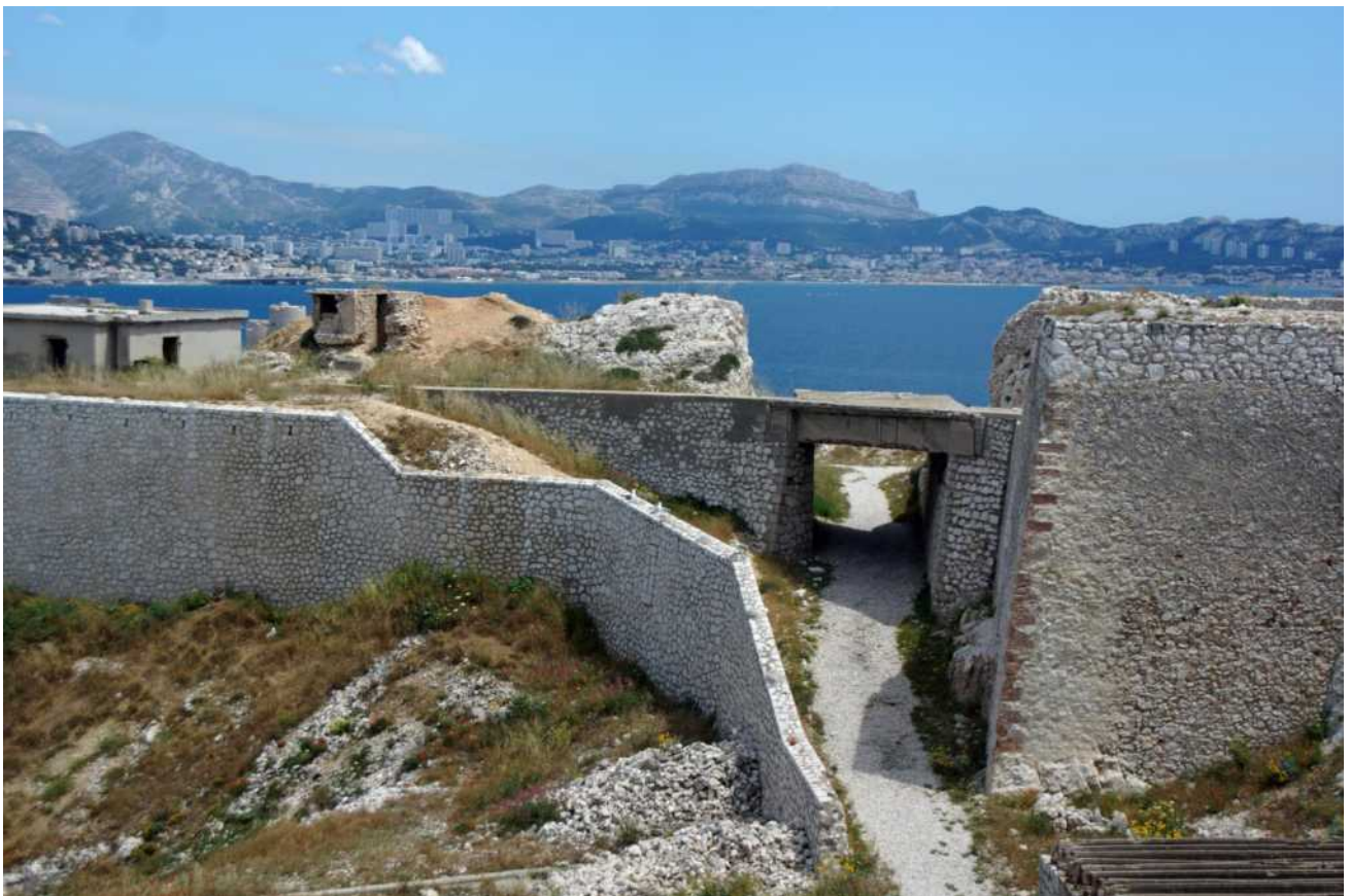
Chemin d'accès et porte d'entrée en arrivant depuis la plage de Saint Estève
