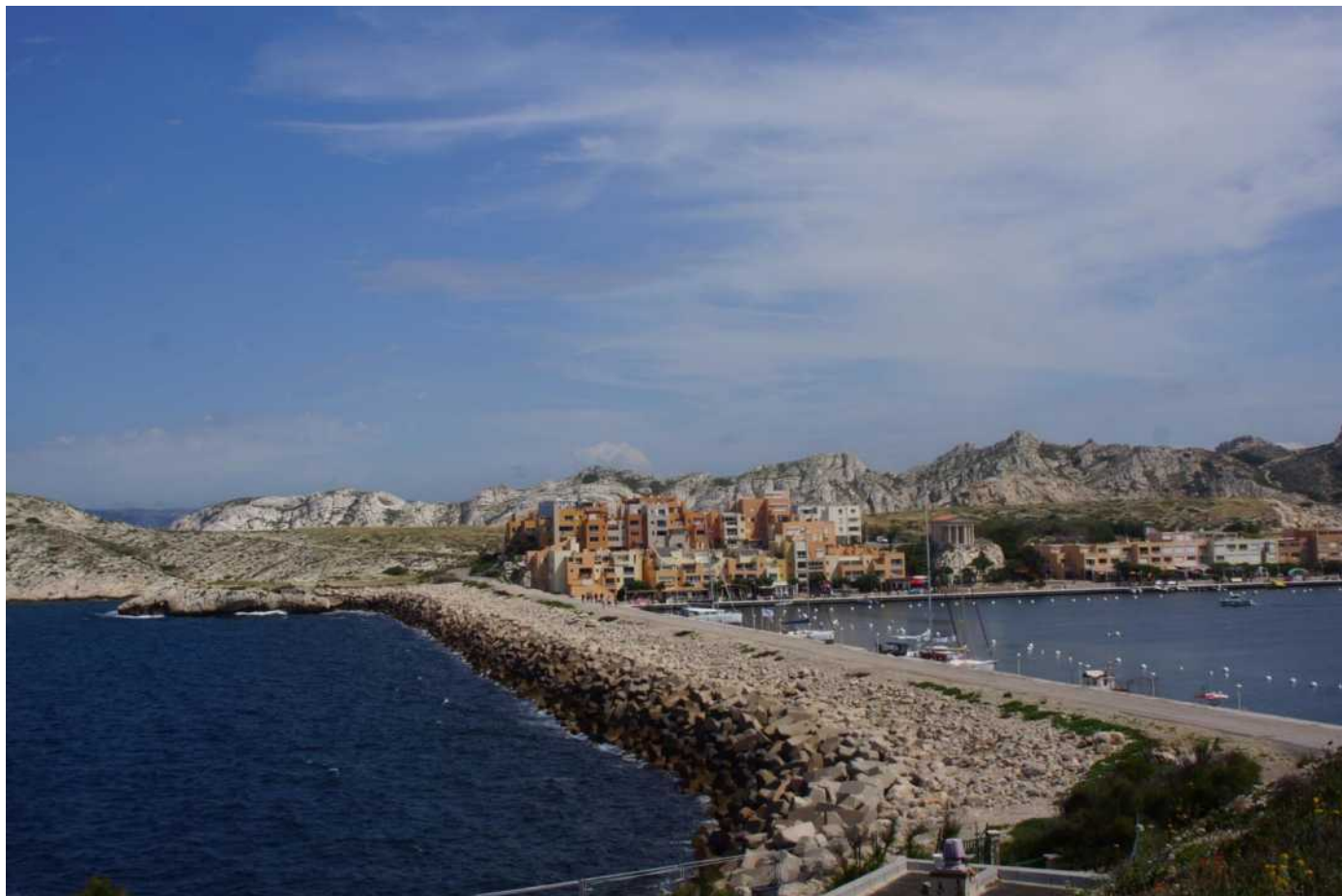
La digue et son enrochement au fond les habitations construites à partir de 1975 sur Ratonneau
