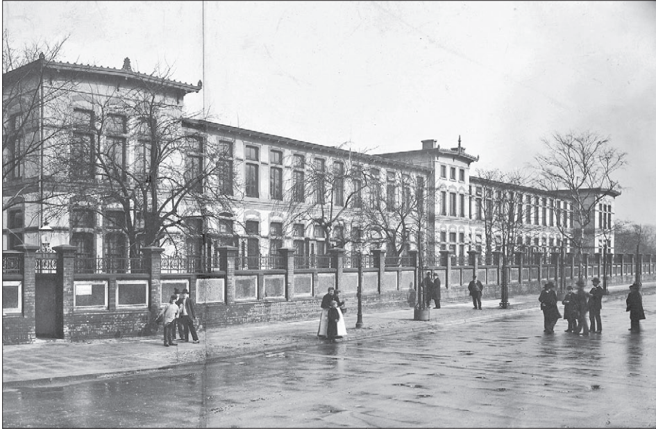
Abb. 7: Straßenansicht des neueröffneten Hafenkrankenhauses an der Seewartenstraße, 24.4.1901. Fotograf: G. Koppmann, Quelle: Staatsarchiv Hamburg, Plankammer 720-1/1_134-6 = 91/81
