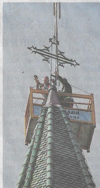
Die Bolzen werden von den Zimmerleuten gelöst. FOTO: JENS SCHLEHE
