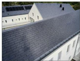
Die eingesetzten Photovoltaik-Module fügen sich bündig in das vorhandene Verlegeraster ein.
