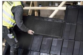
Die hochmoderne PV-Indach-Lösung integriert sich optisch durch das Zusammenspiel mit dem Trendziegel J160 optimal ins Dach.
