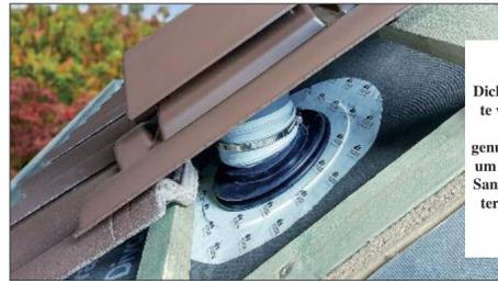
Die Unterspannbahn-Dichtmanschette von FLECK kann u. a. genutzt werden, um die FLECK Sani Extra Lüfterpanne luftdicht anzuschließen.
