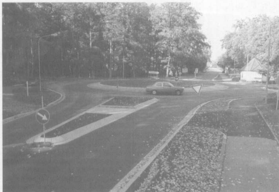
Am südlichen Ortsein-/ausgang: Kreisverkehr – sichere Kreuzung für alle Verkehrsteilnehmer.
