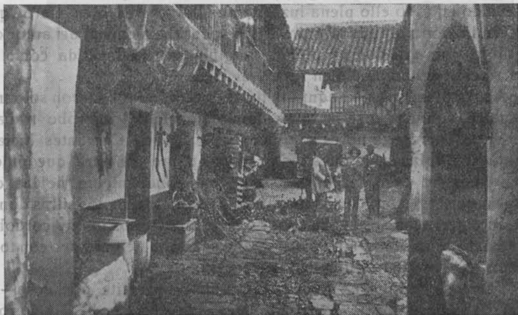
Patio de entrada de la Posada del Potro, antes de la novación de su pavimento, conservando todo el ambiente que tenía en el siglo XVI.
