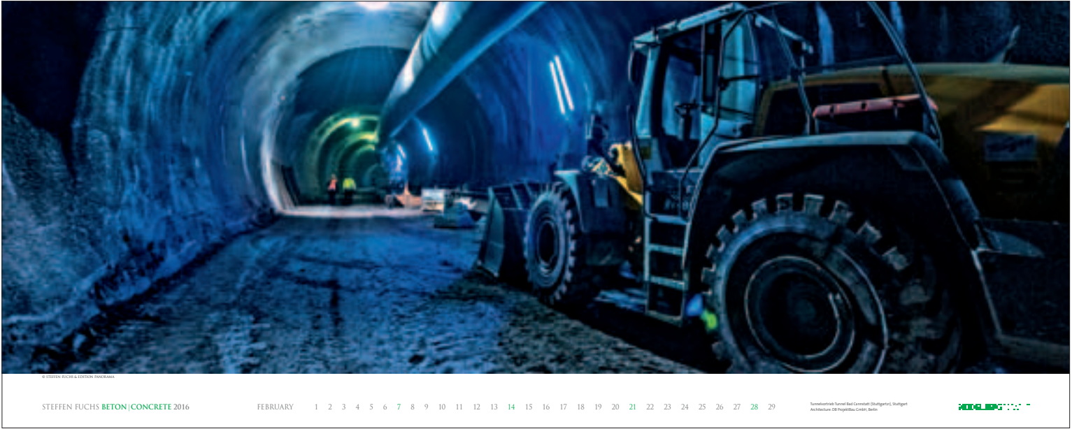
2. Tunnelvortrieb Tunnel Bad Cannstatt (Stuttgart1), Stuttgart Architecture: DB ProjektBau GmbH, Berlin
