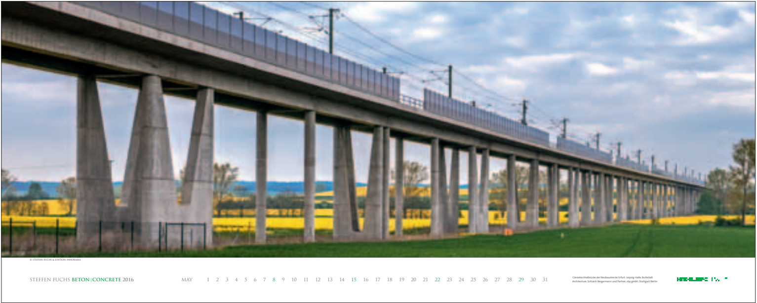
5. Gänsebachtalbrücke der Neubaustrecke Erfurt- Leipzig-Halle, Buttstädt Architecture: Schlaich Bergermann und Partner, sbp gmbh, Stuttgart/Berlin
