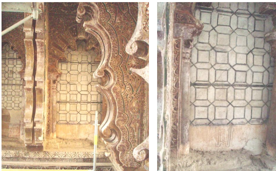
Figs. 35 y 36. Ventanales de la Capilla Real
